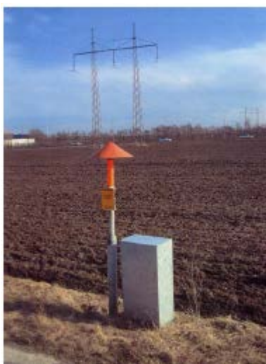
Figur 4:1. Gasledning som går nära och parallellt med en högspänningskraftledning (foto: G. Camitz)
