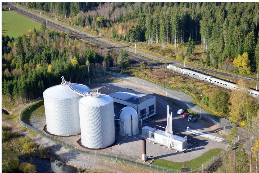
Figur 2 Göteborg Energis biogasanläggning i Sävsjö. Källa: Purac Puregas AB.
