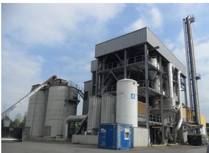
Figur 6 Foto av Oberwarts kraftvärmeanläggning i Österrike, där syngas produceras från fergasning av flis som sedan förbränns i Jenbachers gasmotorer till kraftvärme. Foto: Anna-Karin Jannasch.
