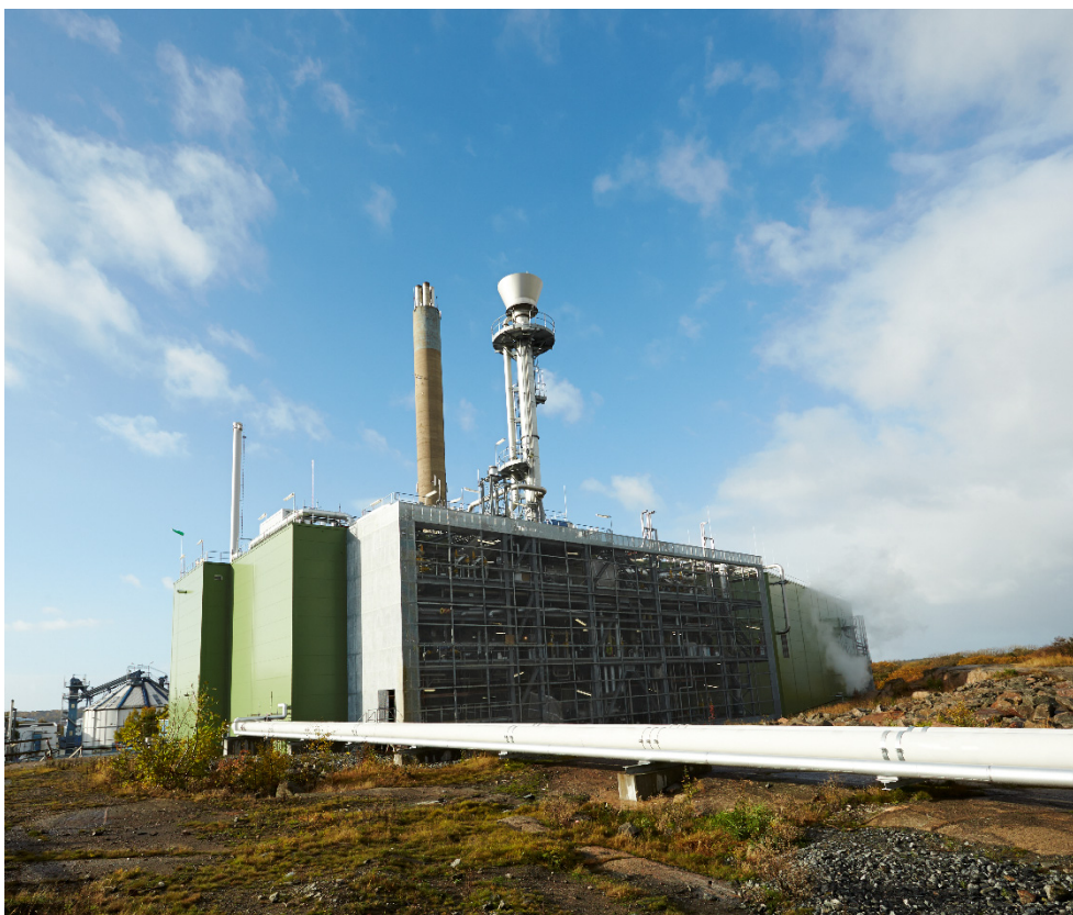
Figur 4 GoBiGas - Världens största demonstrationsanläggning för produktion av biometan. Källa: Göteborg Energi AB. Foto: Rob Vanstone.
