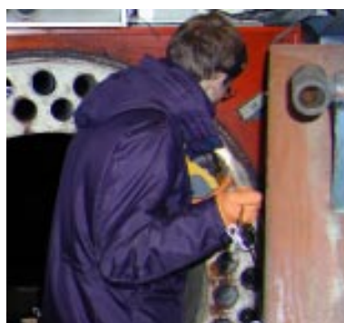
Katalysator-näten monteras på stänger som skjuts in i pannans tuber.
