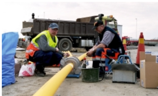
Rör tillverkade i PE-100 kan i Sverige användas för distribution av naturgas vid tryck upp till 10 bar. Rören kan både stumsvetsas, som på bilden, och svetsas med elektromuffar.
