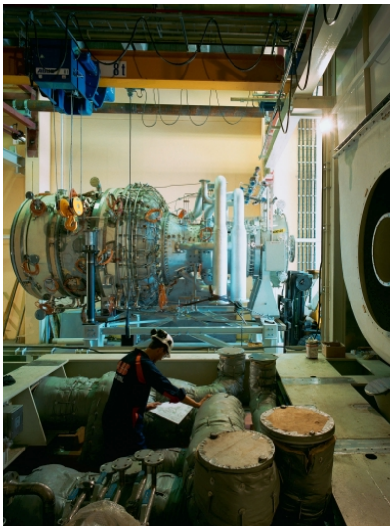
Världens första GTX100 lyfts på plats. (Foto: ALSTOM Power Sweden AB.)
