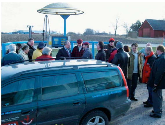
Intresset för de svenska erfarenheterna av uppgradering av biogas är stort ute i Europa. Bilden är tagen vid ett internationellt besök på uppgraderingsanläggningen i Eslöv.
