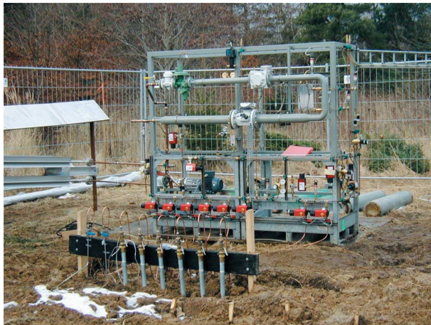
Vid Dansk Gasteknisk Center als har en försöksanläggning byggts upp där systemkomponenter kan testas i vätgasatmosfär.
