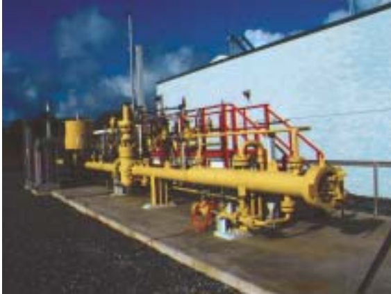
Stavanger försörjs med naturgas från Statoils anläggning på Kårstø via en sjöledning som kommer iland i Risavika strax söder om Stavanger. Där reduceras trycket i en MR-station och leds vidare i plaströrssystem vid 10 bars tryck.
