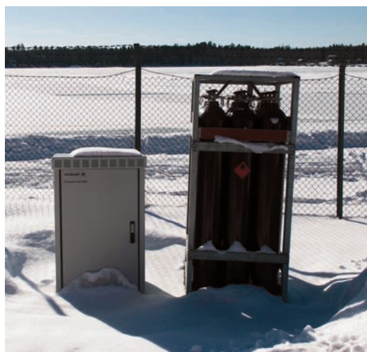
Aggregatet Vinterström på Lidingö vintern 2004/2005.
