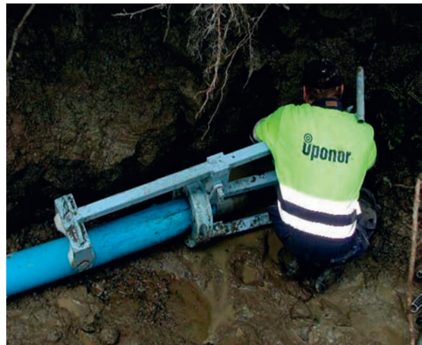
Mantlade plaströr har under de senaste åren i stor utsträckning ersatt de konventionella homogena rören vid läggning under svåra förhållanden. (Foto: Uponor)
