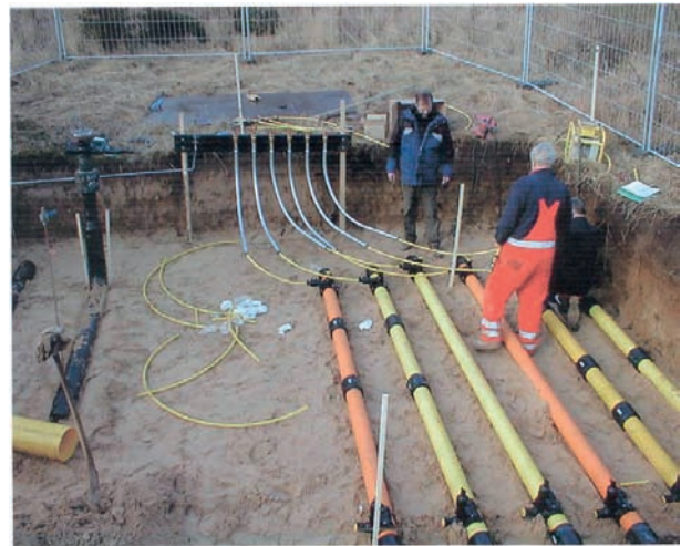
I DGC:s gasnät i Hørsholm, Danmark, undersöks möjligheten att distribuera vätgas i naturgasnätet. (Foto: DGC)
