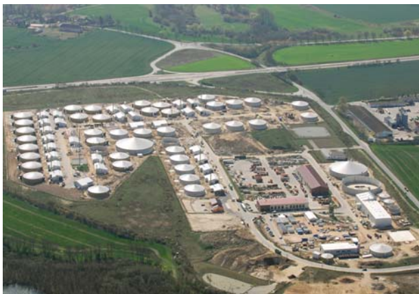
I Penkun i Tyskland finns denna energipark, bestående av 40 standardiserade biogasanläggningar med en sammanlagd produktion på 20 MW effekt. (Foto: ©NAWARO BioEnergie AG)
