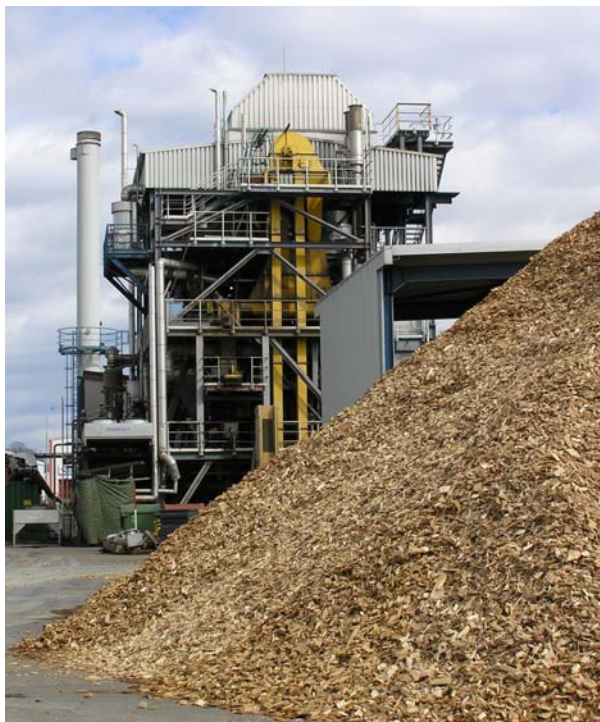
I Güssing, Österrike, demonstreras produktion av biometan från träflis via förgasning och metanisering inom EU-projektet Bio-SNG.
