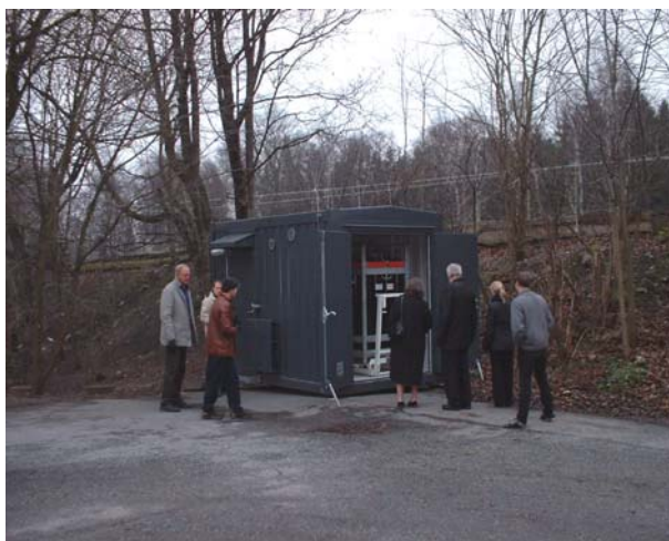
Container innehållande bränslecellsystem, vätgaslager och kringutrustning.
