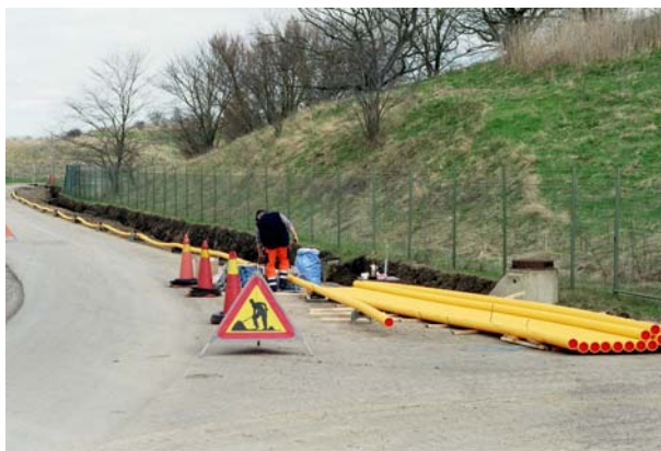
I dag används nästan uteslutande polyetenrör för distribution av energigaser i tryck understigande 4 bar.
