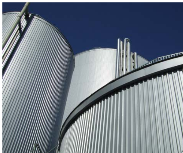
Den i dag etablerade metoden för hygienisering är pastörisering vid 70 °C i en timme. Här ses tre hygieniseringstankar vid biogasanläggningen i Västerås.
