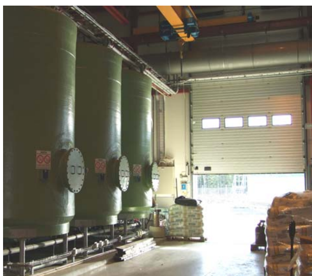
Den i dag etablerade metoden för hygienisering är pastörisering vid 70 °C i en timme. Här ses tre hygieniseringstankar vid biogasanläggningen i Västerås.
