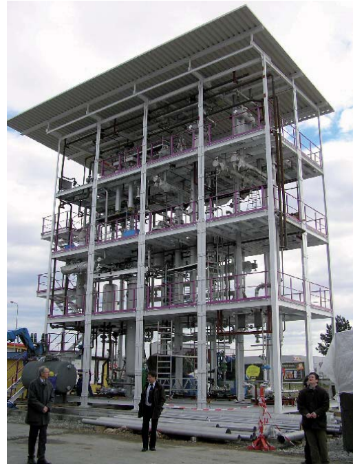
Metaniseringsenheten vid anläggningen i Güssing, Österrike.
