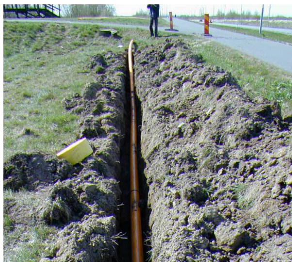
Förläggning av polyetenrör i rörgrav.
