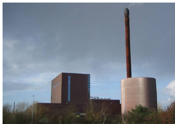
Förgasningsanläggningen i Skive, Danmark (Carbona).
