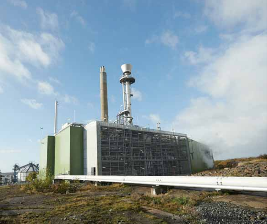
GoBiGas – Världens största demonstrationsanläggning för produktion av biometan.
