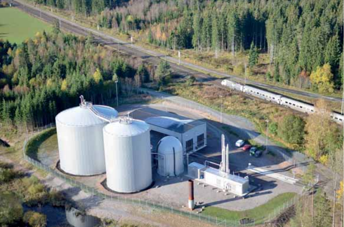
Göteborg Energis biogasanläggning i Sävsjö. Källa: Purac Puregas AB.
