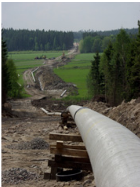
Läggning av transmissionsledningar för naturgas.
