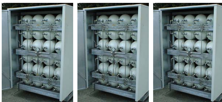
Figur 3 Gaslager med kassetter indelat i Låg + mellan + högbank
