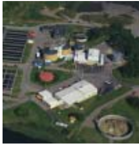
Avloppsreningsverk med slamrötning (Industri med rötning/anaerobfilter)
