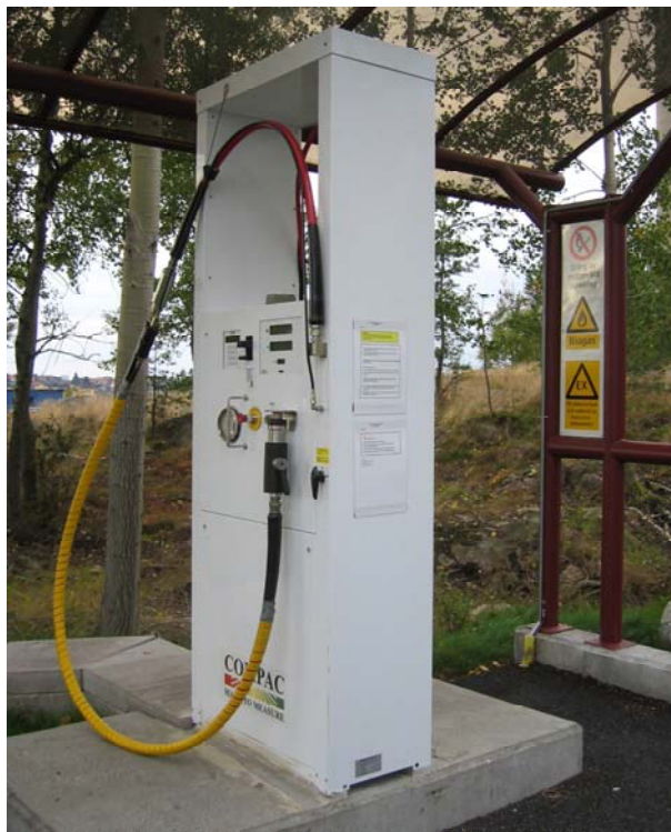
Figur 28. Snabbtankningsdispenser för biogas.
