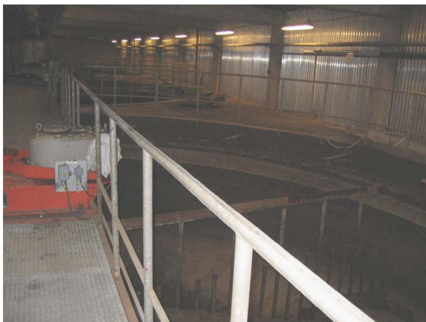
Figur 16. Byggnad för slambehandling
