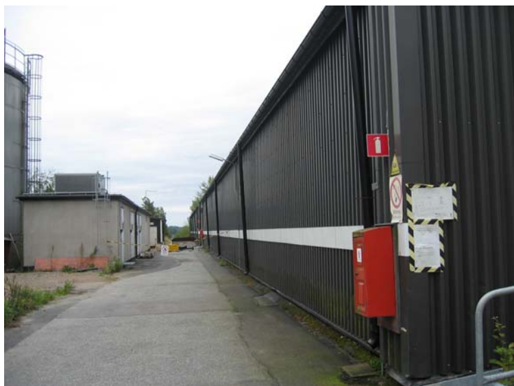
Figur 15 Aktuell byggnad för placering av gasbehandlingsanläggning (höger i bilden)
