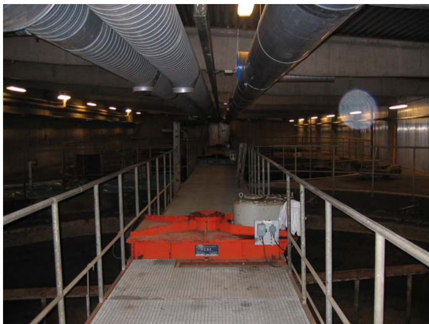
Figur 17 Byggnad för slambehandling
