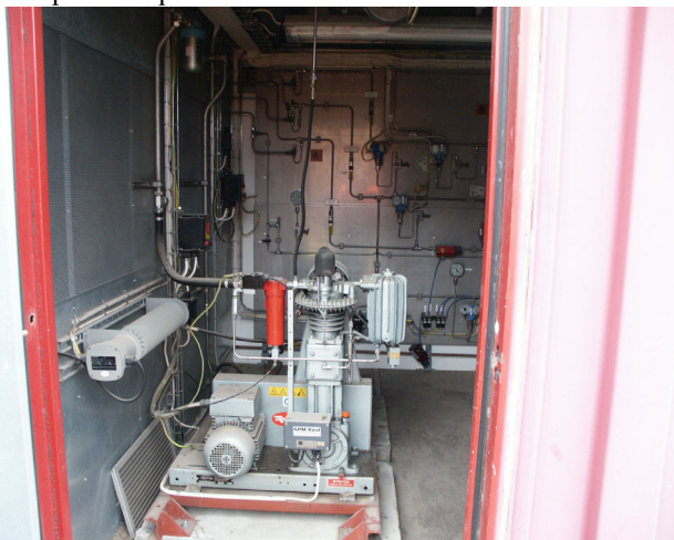
Bild 6. Lågtryckskompressor 1 och vägg med prioritetspanel
