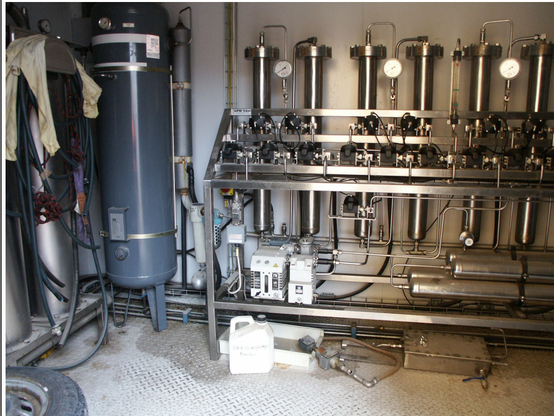
Bild 2. Bufferttank och PSA-filter
