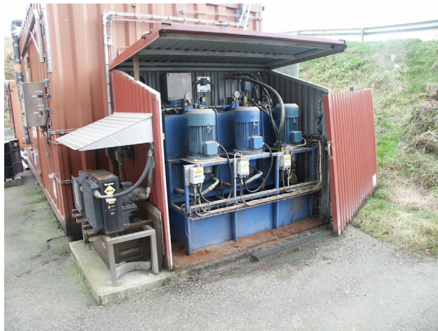
Bild 6. Lågtryckskompressor 1 och vägg med prioritetspanel
