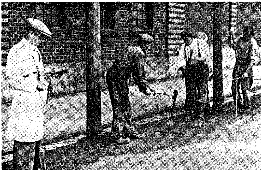
Läcksökning av gasledningar under mark 1930.
