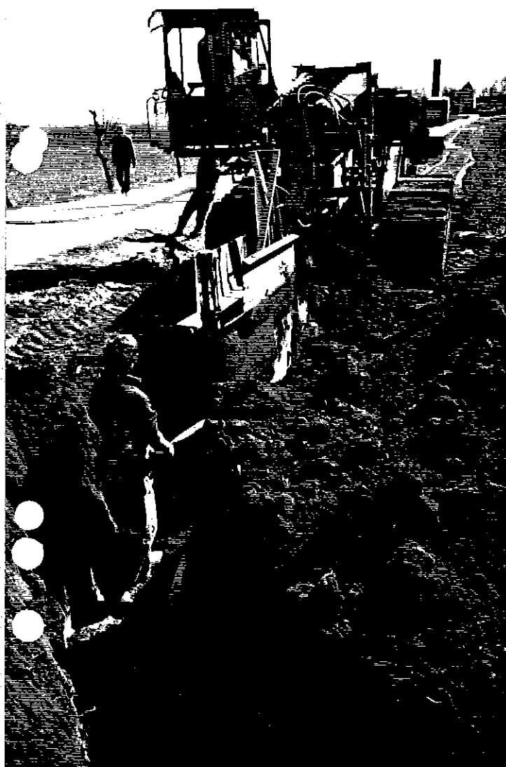
Plögen och läggboxen sänks ned i startgropen varefter plöjningen påbörjas.
