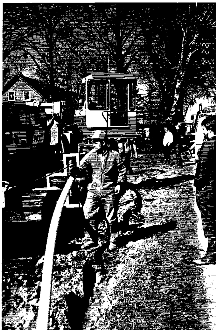
Gasröret leds över dragfordonet och ned i läggboxen via gummidäcksförsedda styrhjul.
