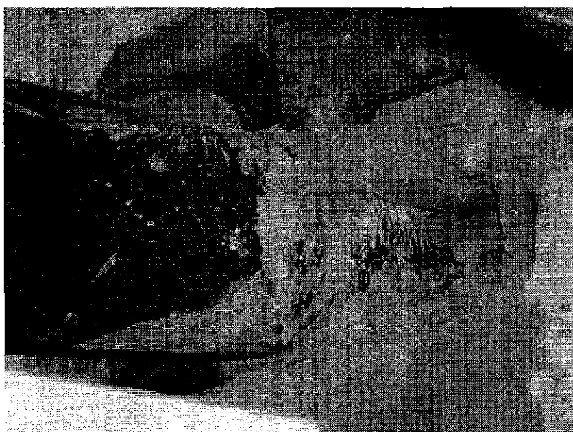
Figur 2.3: Koppling mellan rökrör och insatsrör i installation 15.
