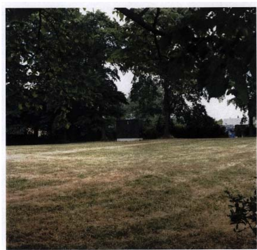
Figur 8 Reglerstation av betongelement i Hjärup, 5 MW anslutningseffekt
