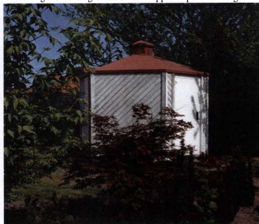
Figur 9 Reglerstation vid Tivolitorget i Laholm, 10 MW anslutningseffekt
