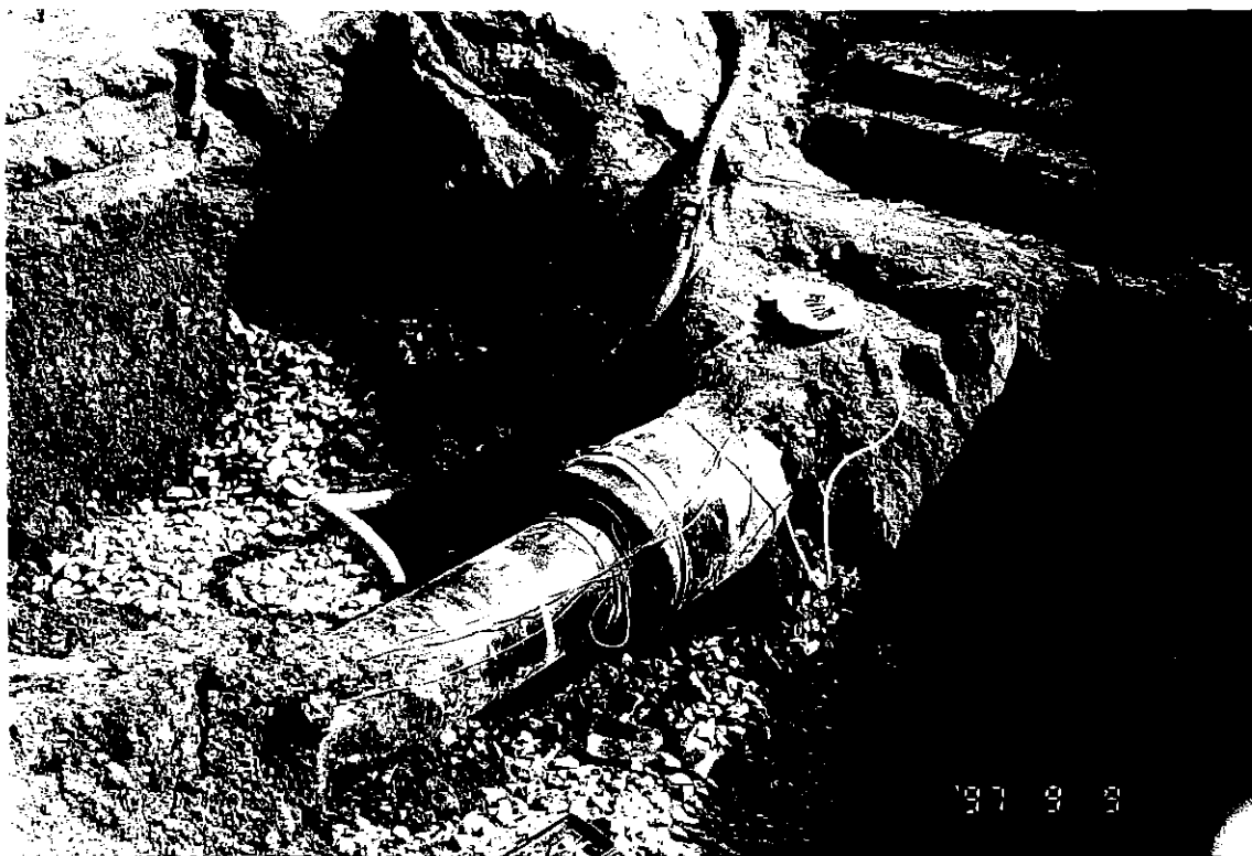
Bild 2 Skyddsrorets södra ände med intakt gummidamask.
