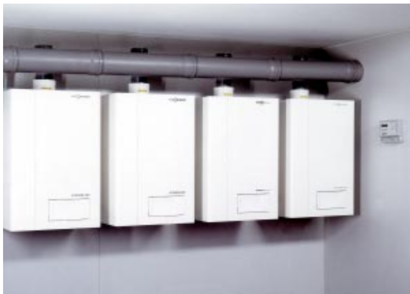
Figur 4.4 Kaskadkoppling av fyra mindre pannor.
