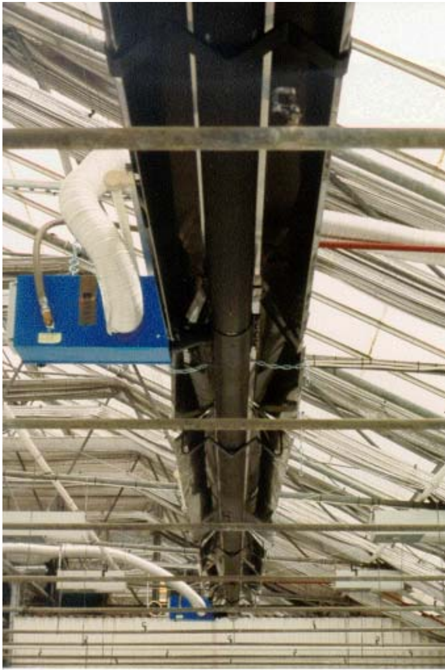
Figur 2.5: Infrastrålarer för övervärmnen (Foto: H.K. Schüssler)
