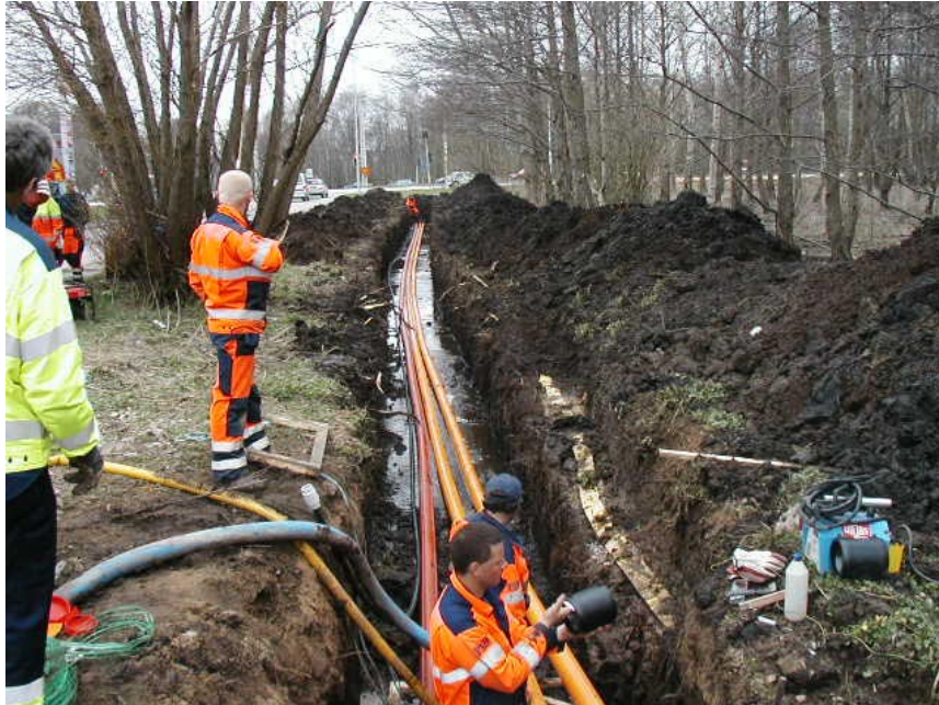
Figur 5. Schaktgrav med tre samförlagda ledningar.
