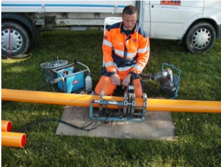
Figur 4. Stumsvetsning av rörledning.
