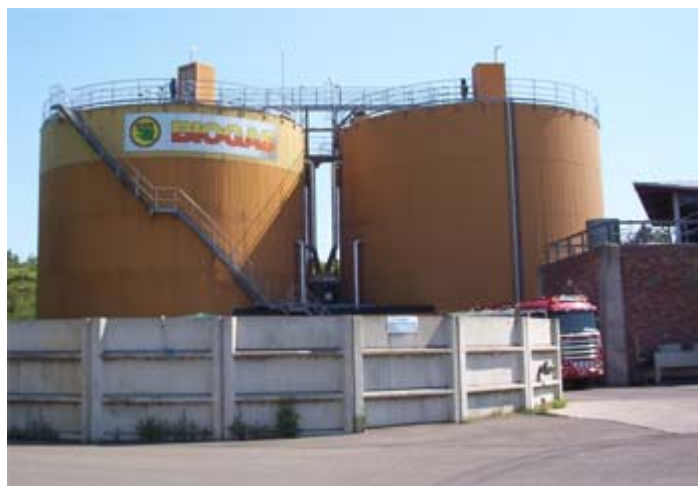
Figur 1: Rötkammare, produktion cirka 300 m 3 rågas per timme (Foto: Margareta Persson)
