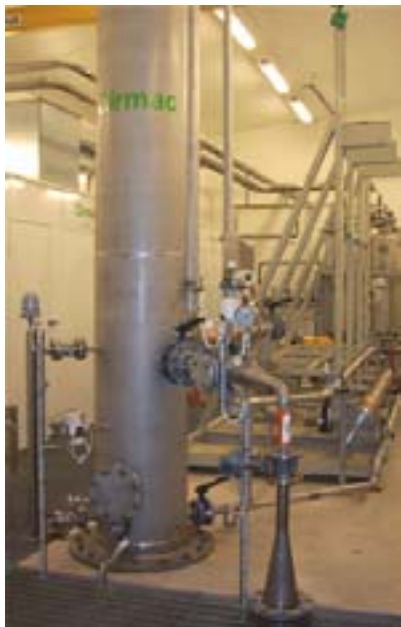
Figur 13: Absorptionskolonn vid absorption med kemisk reaktion (Foto: Margareta Persson)
