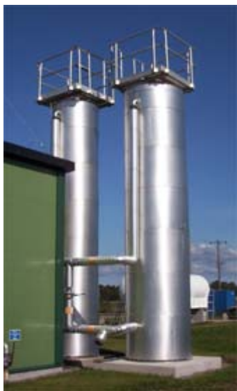
Figur 3: Avskiljning av svavelväte med Sulfa Treat filter® (Foto: Margareta Persson)
