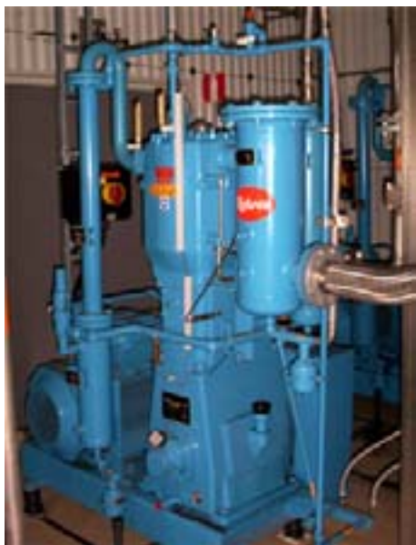
Figur 23: Lågtryckskompressor (Kompressorn på bilden har ingen koppling till texten.) (Foto: Margareta Persson)
