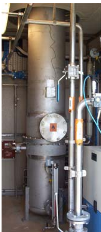
Figur 8: Absorptionskolonn för tryckvattenabsorption (Foto: Margareta Persson)
