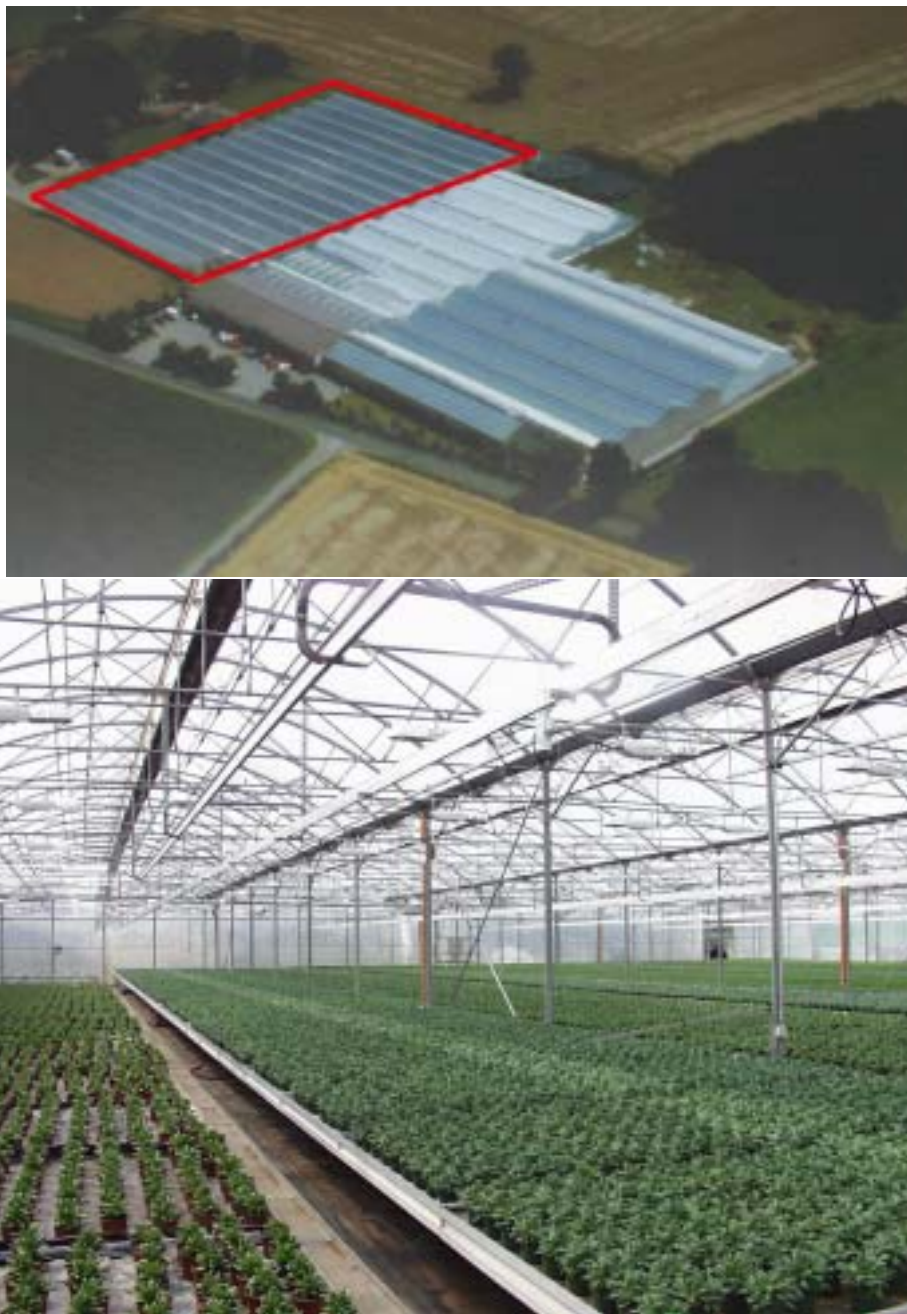
Figur 5.6: Översiktsbilder från Kloer Gartenbau. Överst ses ett flygfoto av hela anläggningen med den IR-värmda delen inom en röd ram och underst ses ett fotografi från denna del med en infrastrålare markerad
