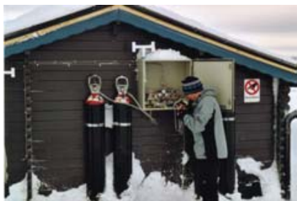
Driftsättning av gasinstallation
