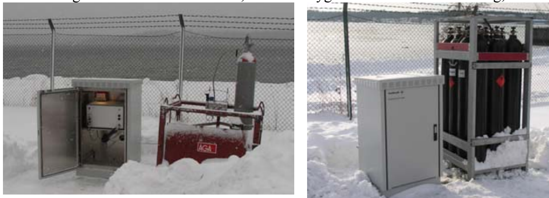
Figur 4. T.v. system vid installationen 14/2. T.h. efter installation av tolvpack gas den 17/2 -05.
