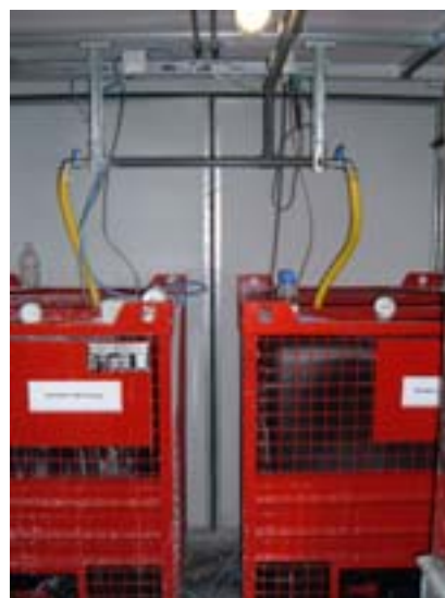
Figur 35. Tillsats av näringslösning och natriumhydroxid (foto: Johan Benjaminsson).
