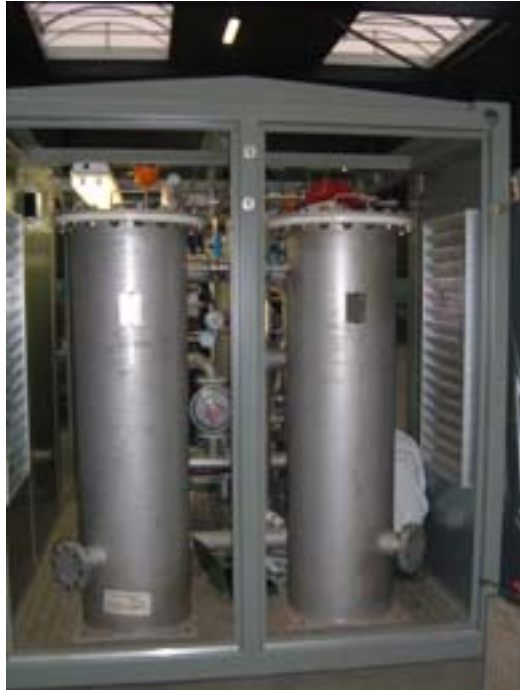
Figur 9. Behållare med järnoxid som reagerar med svavelväte (foto: Johan Benjaminsson).
