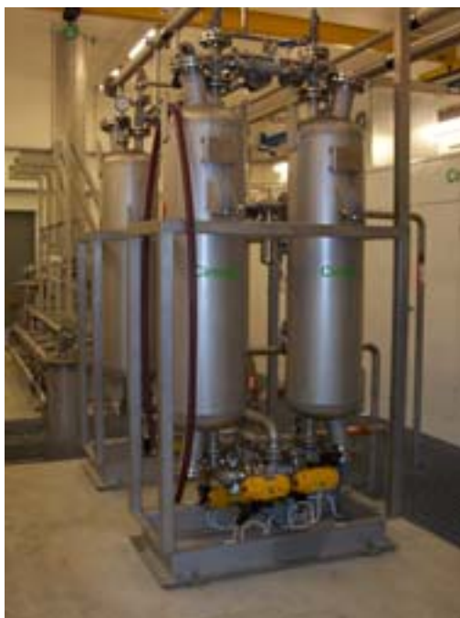
Figur 10. Adsorptionstorkar från Cirmac (foto: Margareta Persson).
