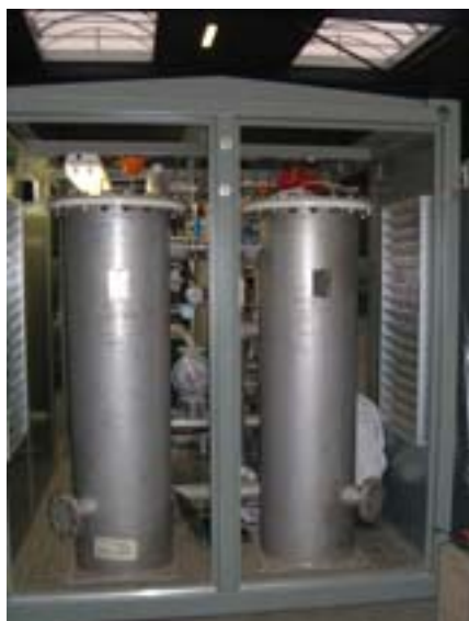
Figur 31. Soxsia-behållare som garanterar siloxanhalten till högst 5 mg/Nm 3 .
