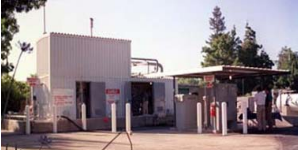
Figur 2: Pilotanläggning i Sacramento. Producerar LNG genom att utnyttja tryckreduceringen i en MR-station, INL.
