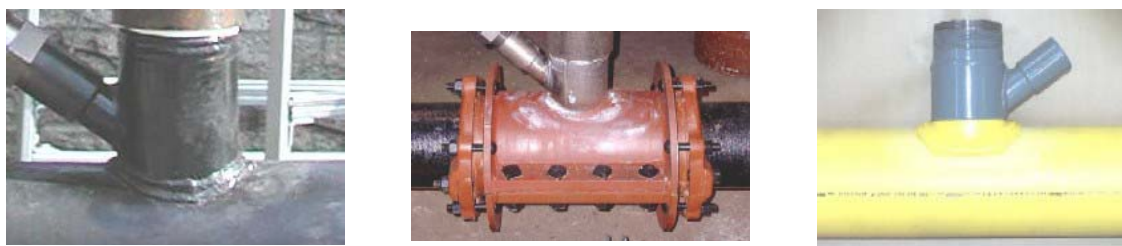
Figur 24. Anslutningar för stål-, gjutjärns-, respektive PE-rör.
