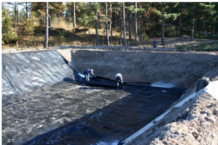
Figur 11. Lagringsbrunn under byggnation 35 .
