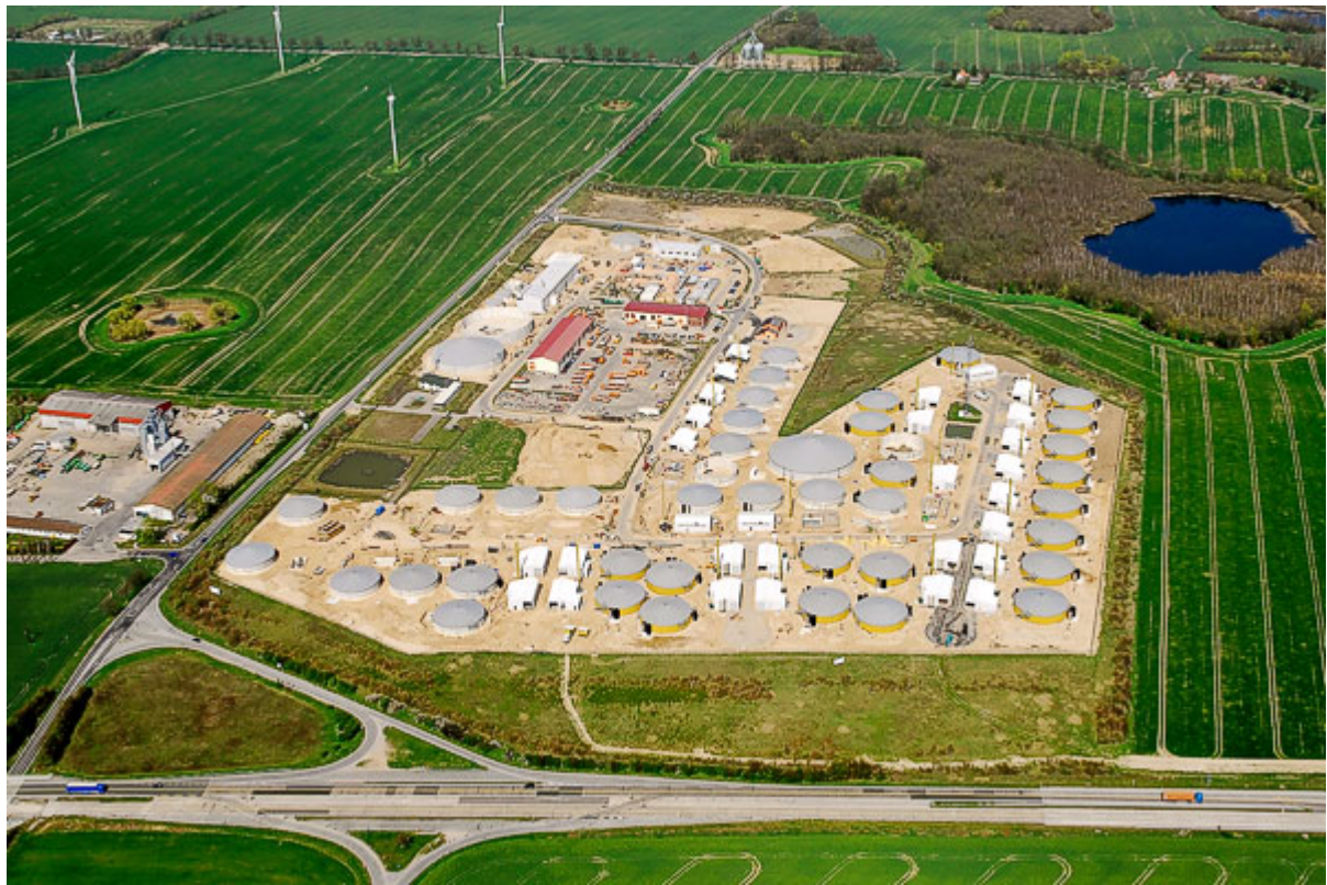
Figur 19. Bioenergipark under uppbyggnad 49 .
