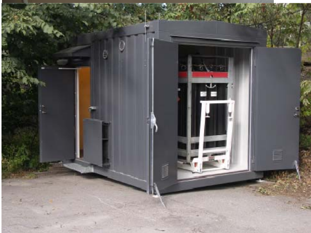
Bilder: Hur bränslecell, rack och container kom att se ut i projektet.
