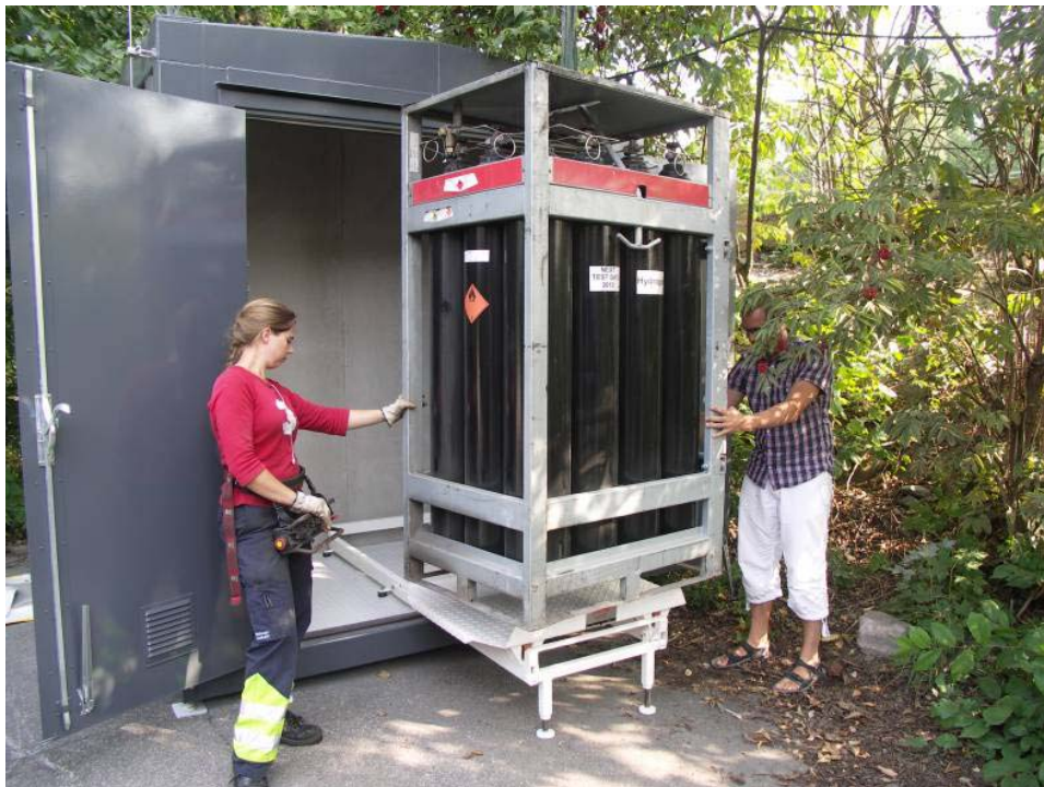
Bild: Leverans av gas från AGA för placering i gasutrymme på container. Skenor utfällda för rullvagn.
