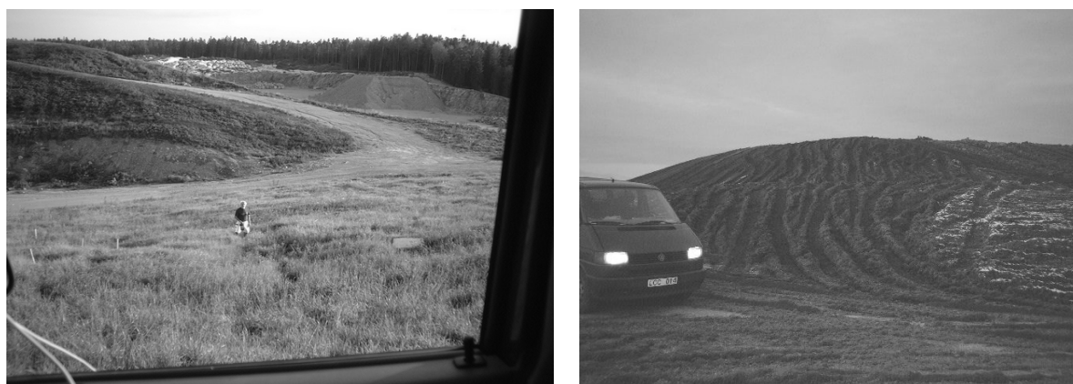
Figur 12.18. Löt, södra slänt före täckåtgärd (v), efter täckåtgärd (h), 200-400 ppm jämfört med 300-10 000 ppm, före åtgärd.
