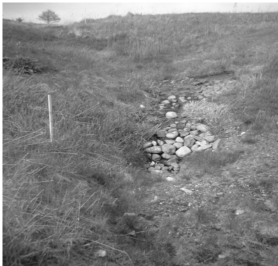
Figur 12.35. (a). Lakvatten-stenkanal med infiltrationsmagasin av sten, metanemission sommartid=>vintertid, 2000-8000 ppm
