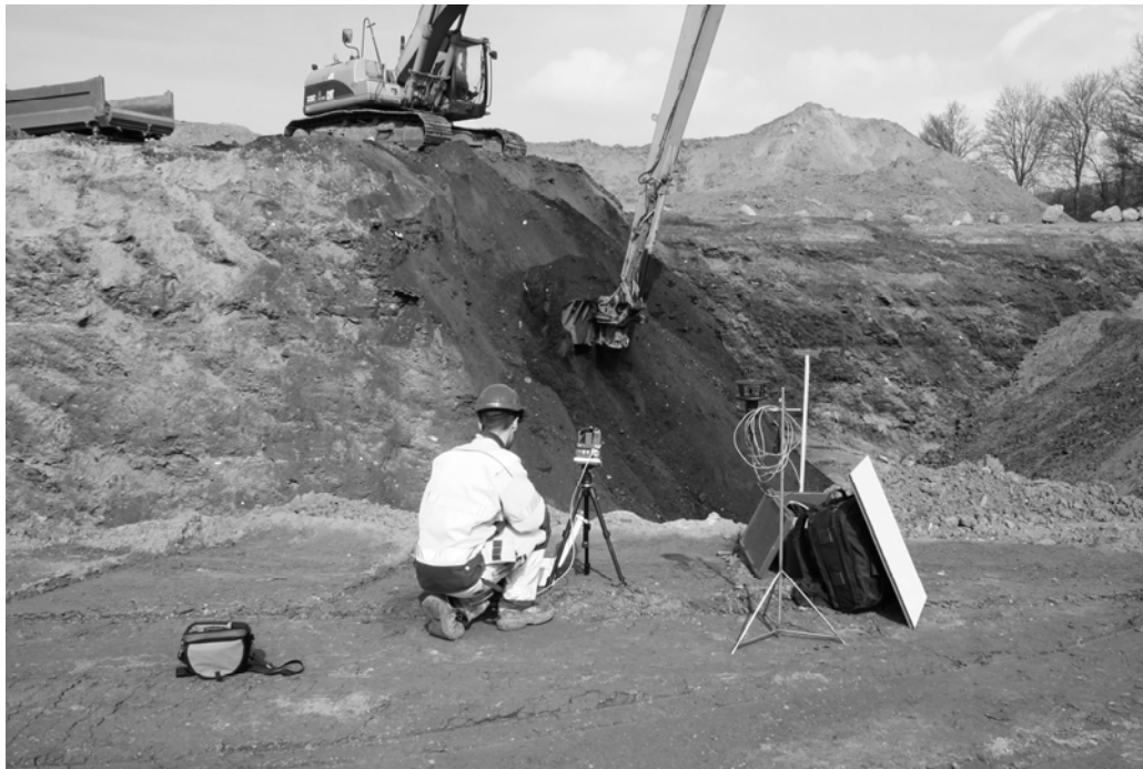
Figur 17.6. Utgrävning av avfall vid Ringstorpsdeponin, Helsingborg 2008. På bilden visas uppställningen av laserinstrumentet riktat mot grävningsplatsen.
