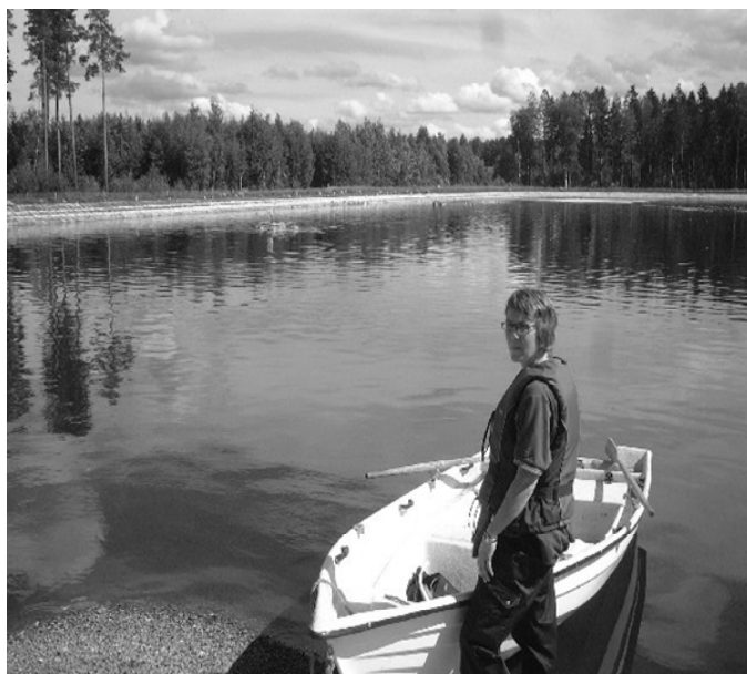
Figur 12.34. (a) LD1, första reningssteget av lakvatten, Forsbacka, 50-200 ppm x m
