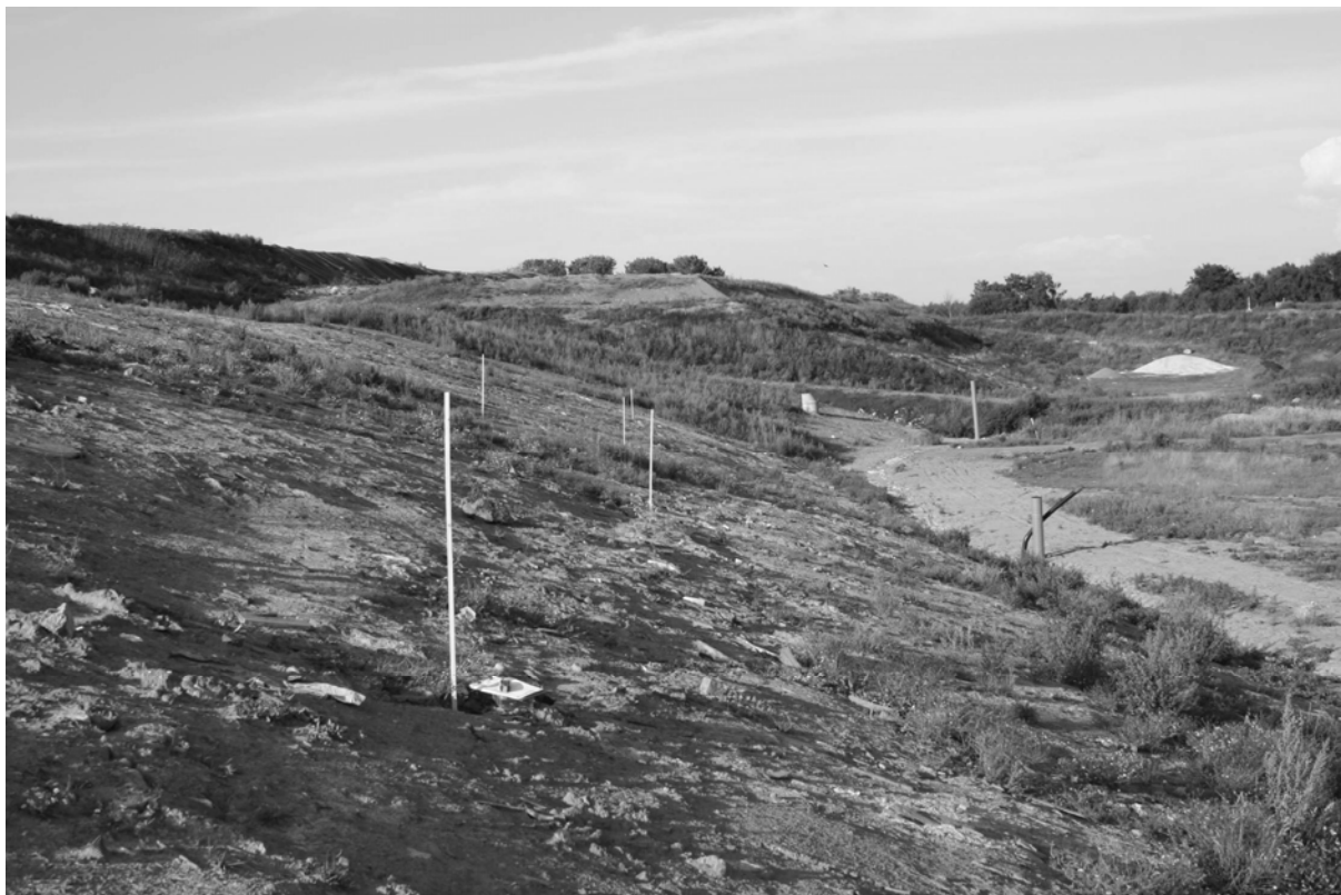
Figur 12.12. Översiktlig bild av östra slänten. Som framgår av bilden ligger alla funna punktsläpp ungefär på samma höjd, och relativt långt ned i slänten. Metanläckage upptäcktes också i lakvattenbrunnarna nedan slänten samt vid en högt belägen sammankopplingsbrunn för gas.
