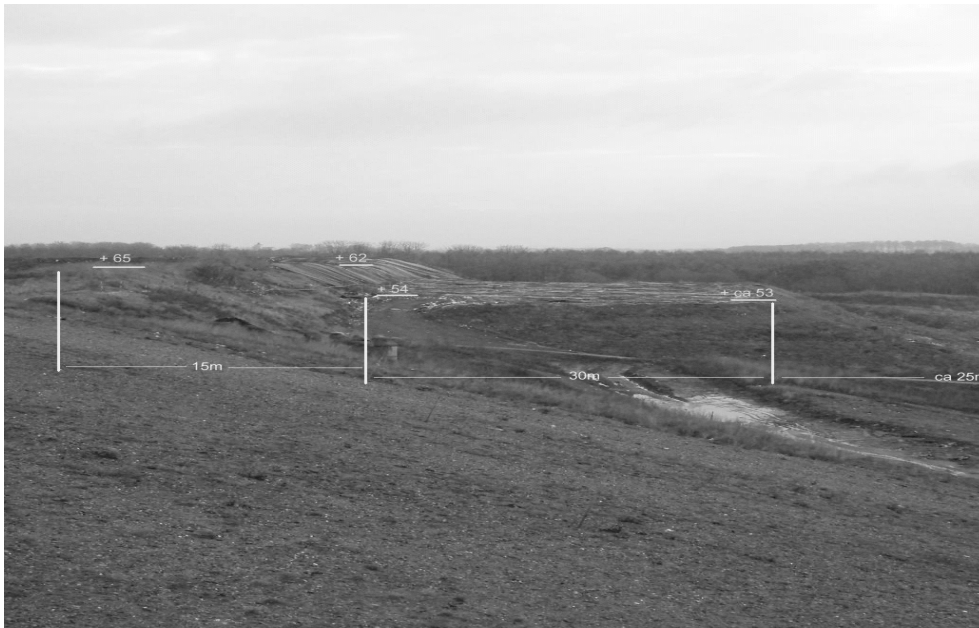
Figur12.7. Filborna-Avfallslager 2005 representerar en plasttäckt överyta på ca 2600 m 2 där ytskiktet perforerats av fåglar. Gasemissionen för ett urval på 127 objekt/hål har detekterats med Siemens laser-system (100-10000 ppm).
