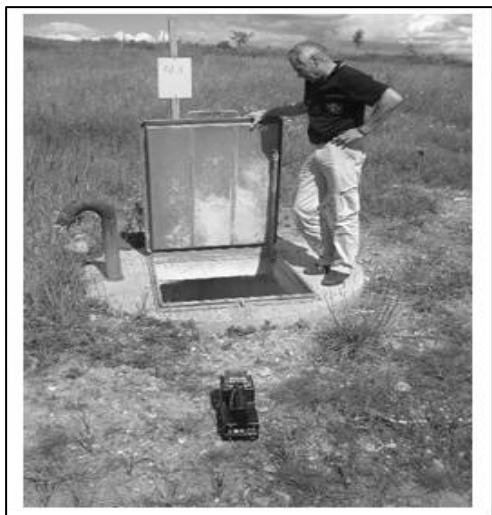
Figur 12.37. Gas-reglerbrunn, Hagby, sommarförhållanden, 6000-10000 ppm
