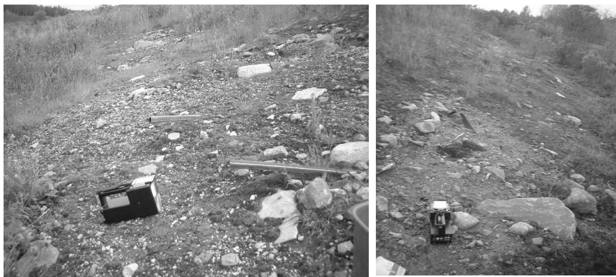
Figur 12.23. Översiktsskildringar av pallkrön F3-området, Forsbackadeponin, från V=>Ö, respektive Ö=>V, med uppstickande föremål, vegetationsfria ytor och mossart med kort rotsystem som återfinns vid ytor med detekterbar metangas.
