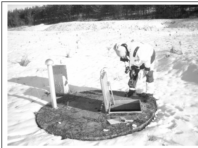
Figur 12.38. Gas-reglerbrunn, Hagby, vinterförhållanden, 6000-10000 ppm.
