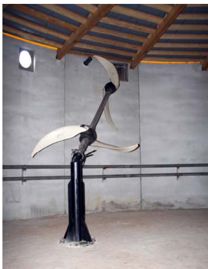
Figur 3.5 Omrörare med lång axel.
