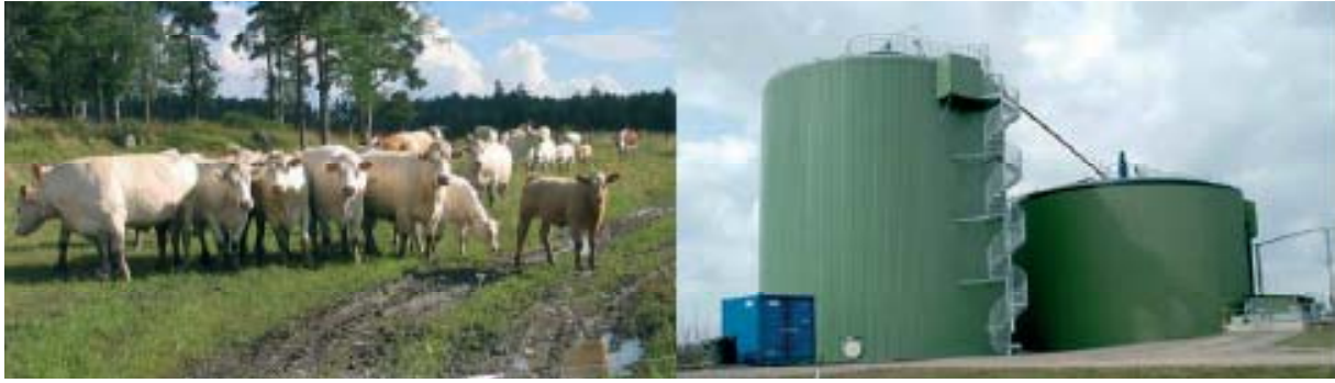
Figur 1. Uppstarten av en biogasreaktor kan ske med gödsel från kor eller med rötkammarinnehåll från en redan fungerande biogasprocess. Foto Anna Schnürer.
