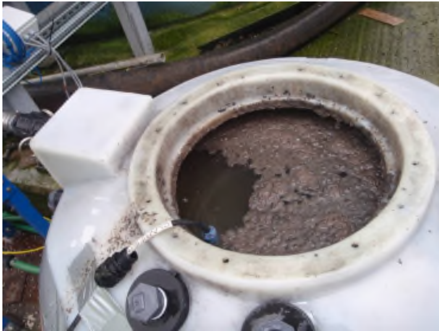
Figur 6.20. Bufferttank för interncirkulation. Notera rejektivattnets kvalitet
