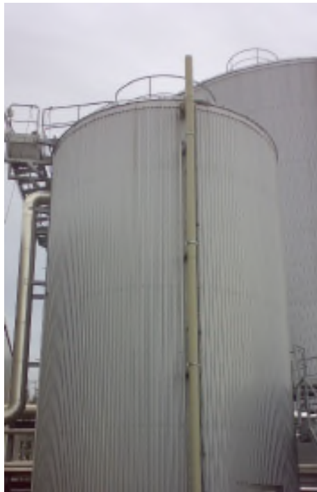
Figur 10. Avluftning från blandningstank.
