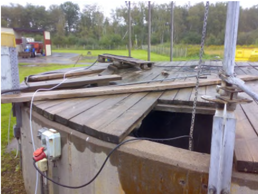
Figur 14. Rötresttank, delvis öppen.
