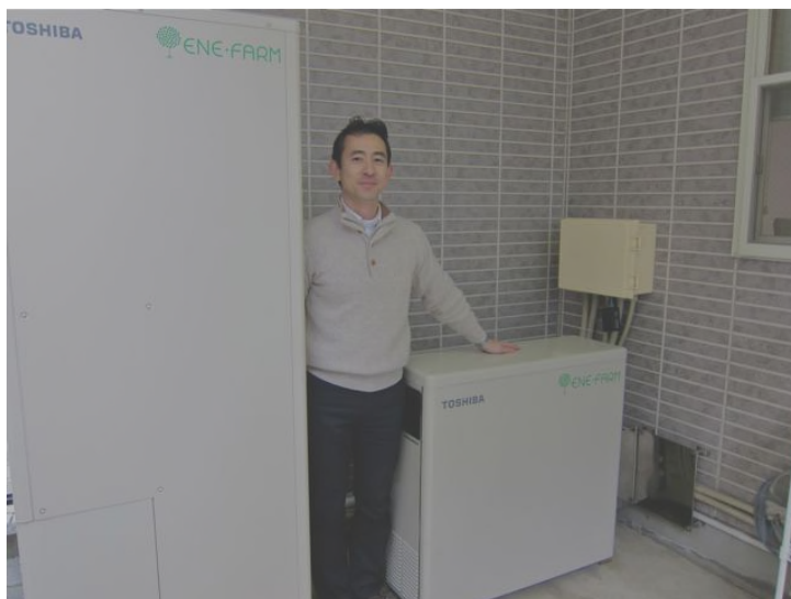
Figur 8.1a. Foto av ENE-FARM. Bränslecellsystemet är integrerat i den mindre boxen till höger och ackumulatortanken (200 L, 60°C) inkl. brännare (40 kW th ) är integrerat i den större boxen till vänster.
