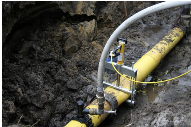
Figur 2. Klämning av gasrör.
