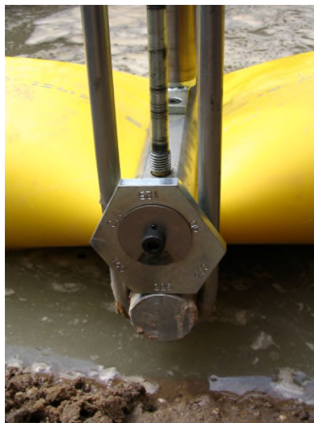
Figur 1. Klämning av ett rör. Foto: HMN Naturgas.
