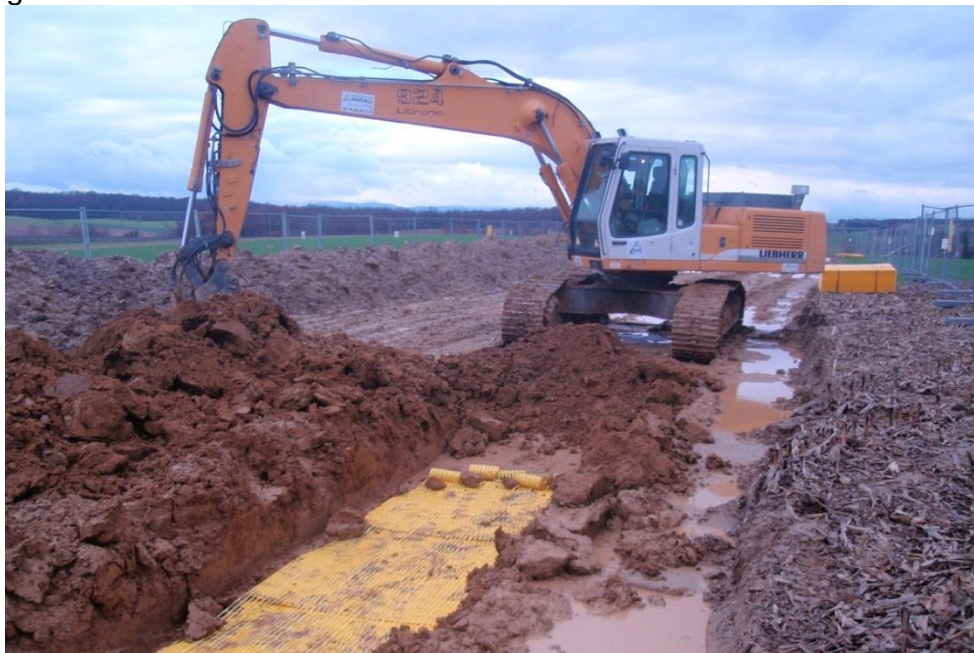
Figur 3: Byggarbetsplats 100 km norr om Lyon där GRTGaz använder PE-plattor som grävskydd.
