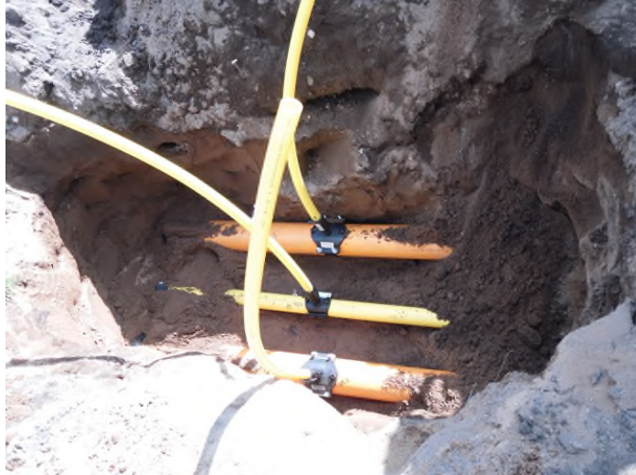
Figur 6. På bilden ses mätobjekten förlagda i gropen. Det lilla mätobjektet låg i mitten och de två mellanstora på 400 mm avstånd, mätt från innerkant till innerkant.
