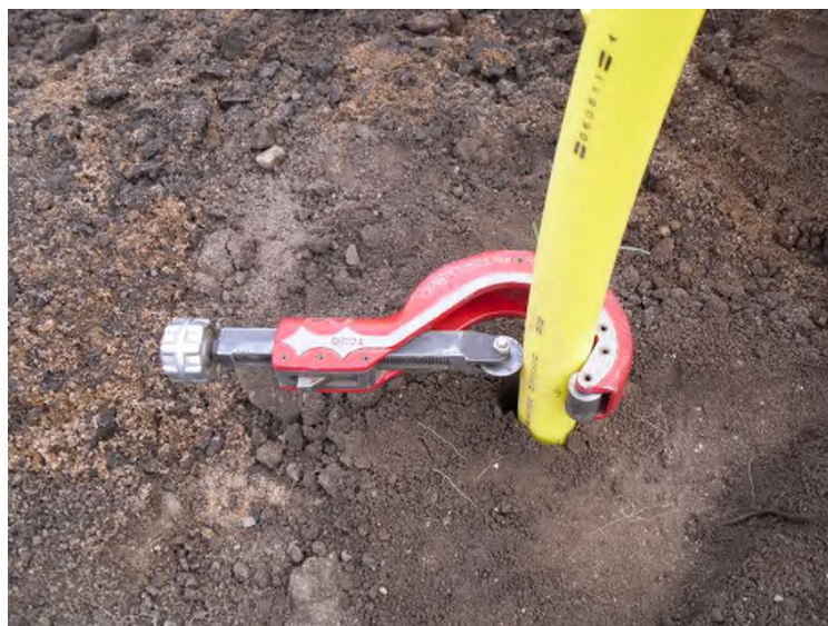
Figur 8. Anslutningsrören kapades så att så lite som möjligt stack upp ovan jord.
