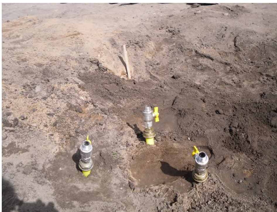
Figur 9. På bilden ses de kapade anslutningsrören försedda med rörkoppling och avstängningsventil.
