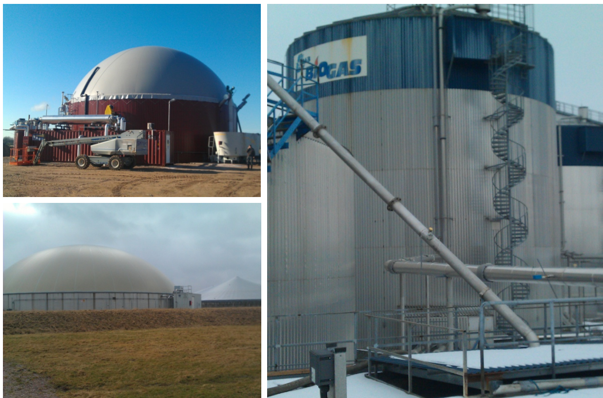
Figur 1: Foton från referensanläggningarna som visar membranklocka på Hagelsrums Gård (uppe t.v.), membranklocka på Wrams Gunnarstorps Biogasanläggning (nere t.v.) och rötkammare på Karpalund Biogasanläggning (t.h.)
