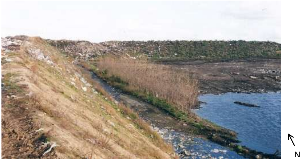
Figur 3.25. Fotografi av vallen i figur 3.20 taget under byggnationen av biocell 300+.
