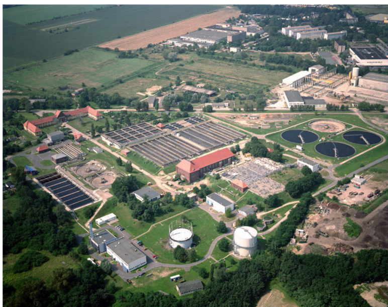
Figur 11- Foto med tillåtelse av Kompetenzzentrum Wasser Berlin gGmbH
