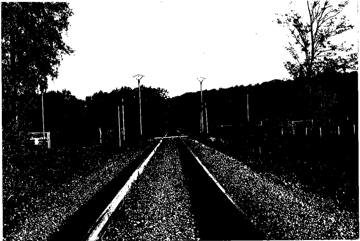
Bild 1 Gasledningen med det undersökta skyddsörret korsar under järnvägen Halmstad-Värnamo vid den obevakade järnvägsövergången, som syns på bilden.
