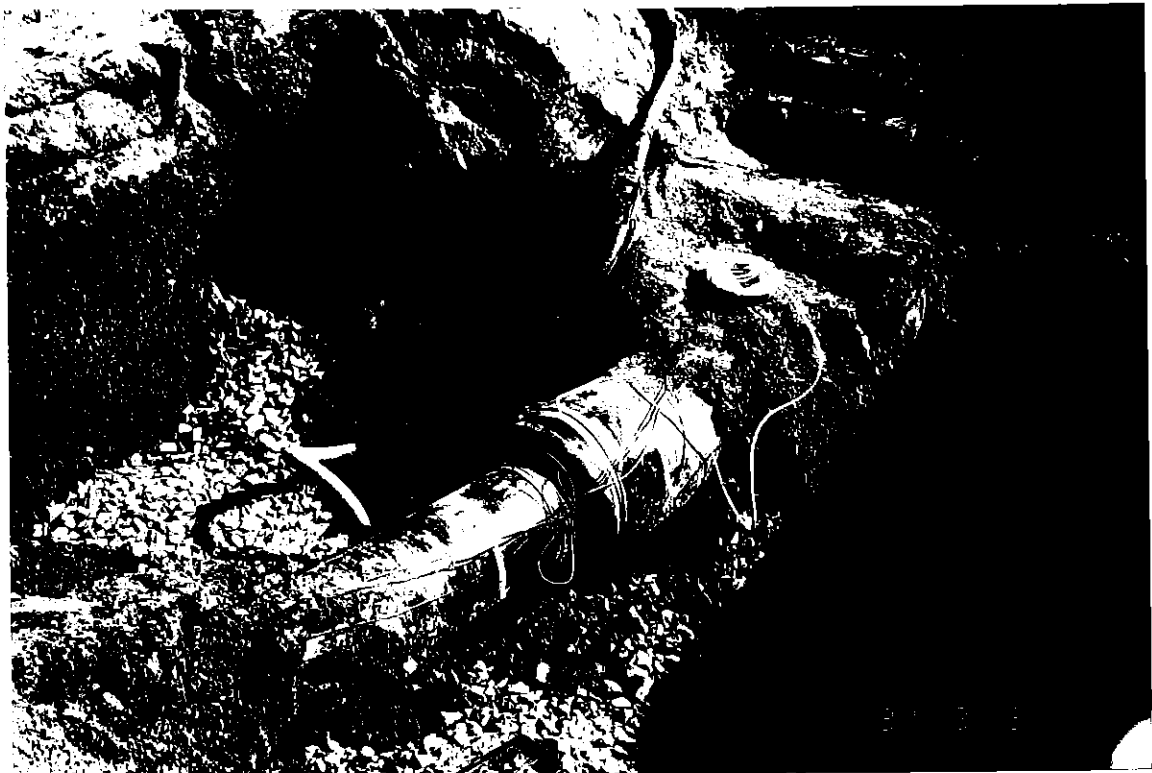
Bild 2 Skyddsörrets södra ände med intakt gummidamask.
