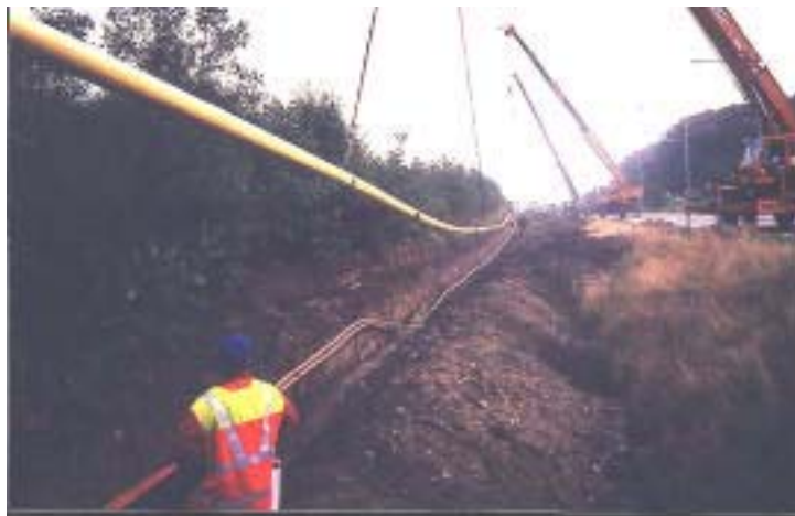
Bild 4. Med hjälp av tre kranbilar sker nedlyftningen av den hopsvetsade ledningen i längder om max 1.400 meter.
