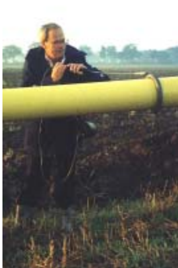
Bild 3. Ledningen gnistprovas vid flera tillfällen innan rören slutligen är på plats i rörgraven. Kontrollen av den 13.200 meter långa ledningen visade på totalt 230 skador i skyddsbelägningen.
