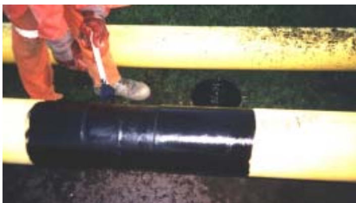
Bild 5. Rörskarven korrosionsskyddas med PE-coating.
