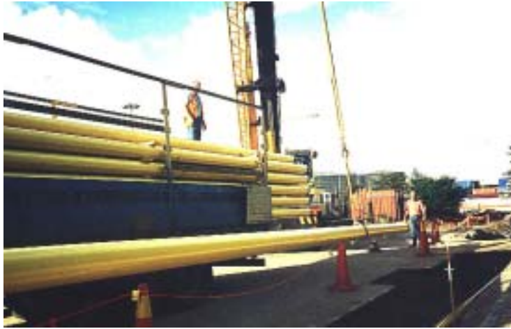
Bild 2. Stålrören med 2 mm gul polyetencoating lastas här av i Helsingborg
