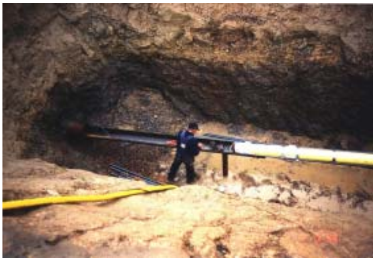
Bild 1. Efter borrhning under motorvägen trycktes ledningen igenom ett skyddsror. På bilden kan man även skönja de glid-skor som håller avståndet till skyddsroret.
