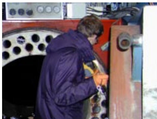
Figur 4.2 Kutsarna skjuts in i pannans tuber och förankras.
