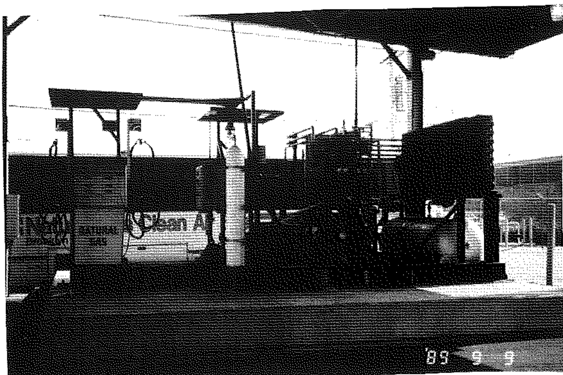
Bild 6. Långsamfyllningstation för Brooklyn Union Gas Companys naturgasdrivna bussar i Brooklyn, N Y, USA.
