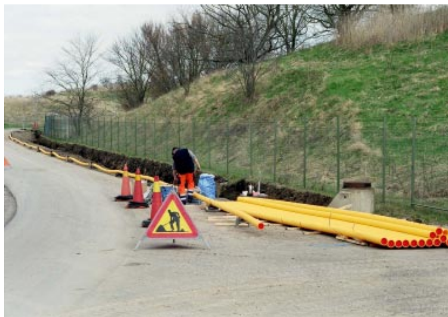
Figur 1. En provförläggning av 600 m PE 100-ledning har gjorts i Linköping
