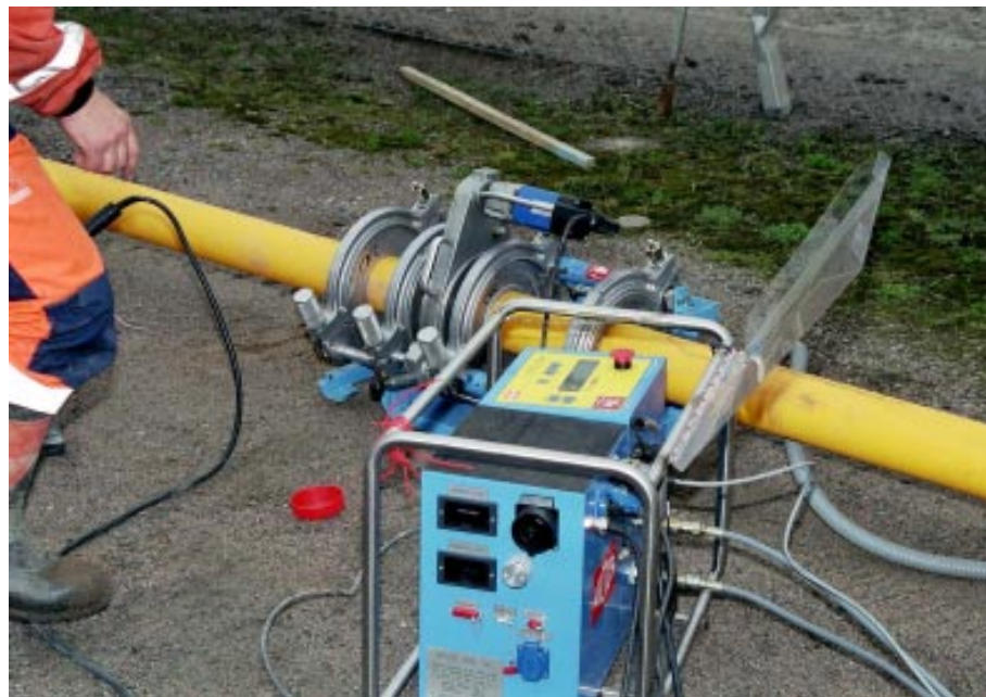
Figur 4. Förberedelser för stumsvetsning pågår.
