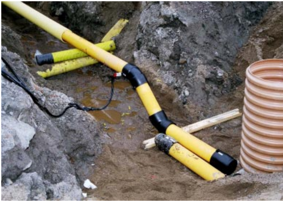
Figur 2. Rörböjar med elektrosvetsade muffar. På bilden syns också ett skyddsör.
