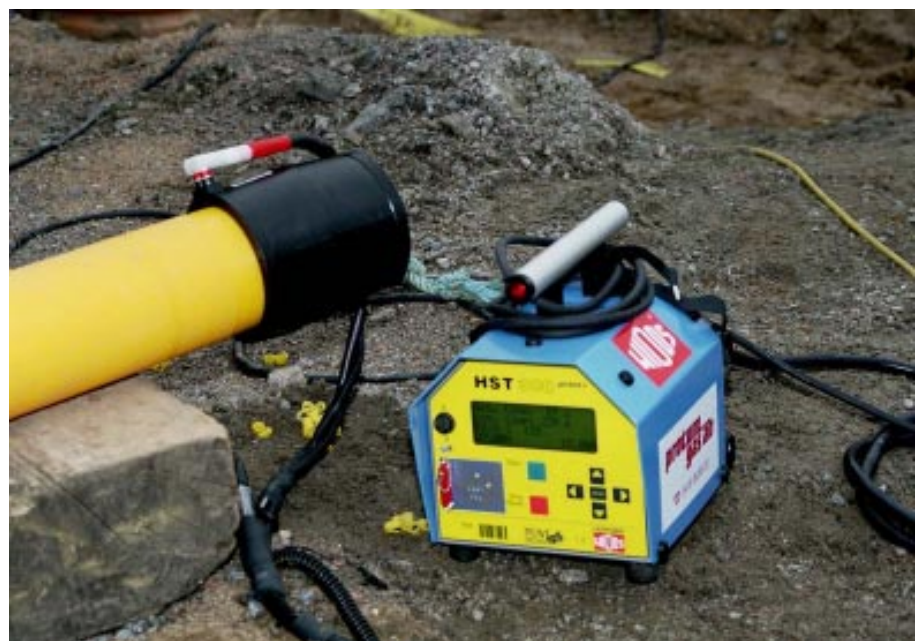
Figur 3. 14 stycken rörskarvar är elektrosvetsade.
